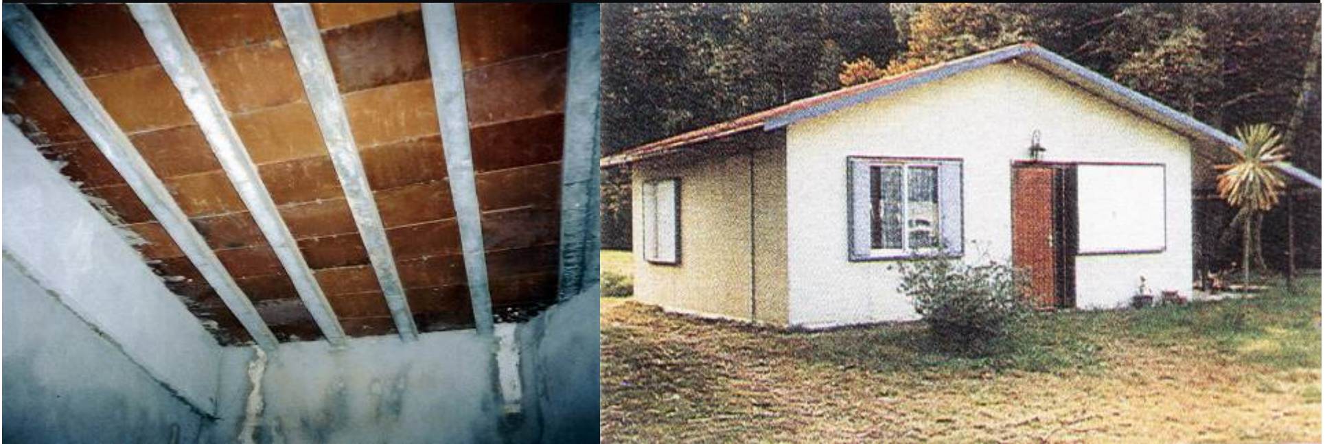
Entrepiso de viguetas y bovedillas - Sistema Scan Housing
